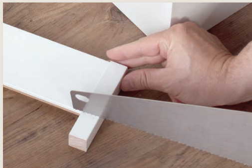
Holzecke bei Bedarf auf Leistenhöhe (+ ca. 2mm) kürzen
