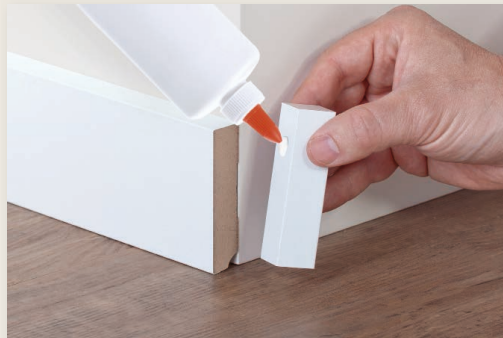
Durch Kleben oder Leimen an den Stirnseiten der Sockelleisten befestigen
